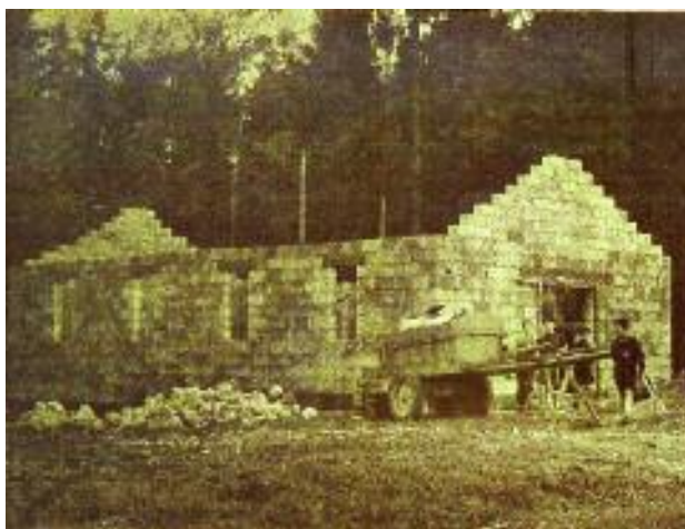
Der Rohbau der Notkapelle ist fast fertig. Le gros-œuvre de la chapelle est sur le point d'être terminé.
