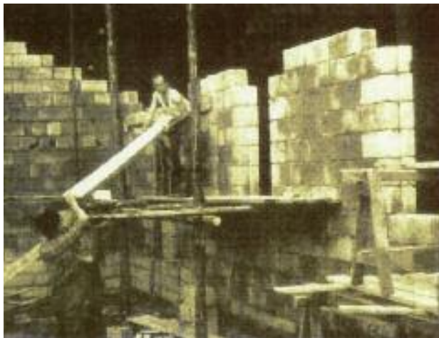
Die Mauern der Notkapelle werden hochgezogen Les parois de la chapelle prennent forme.
